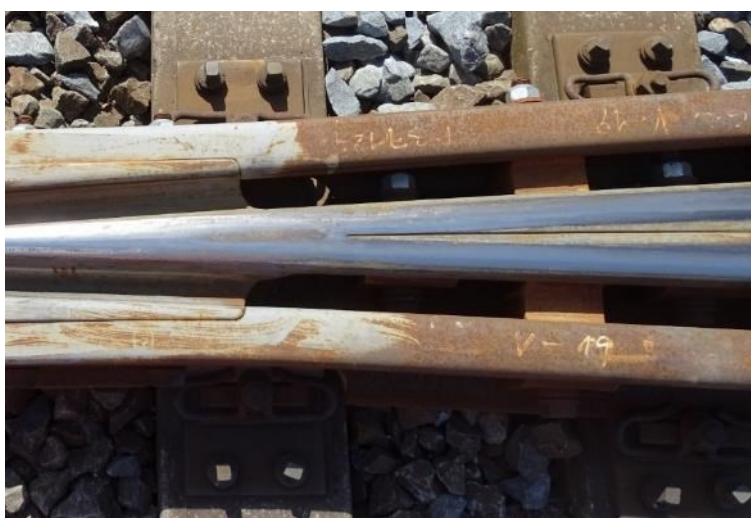
Obrázek 4 - Oblast hrotových kolejnic bez podélného svaru (výroba od roku 2019)
