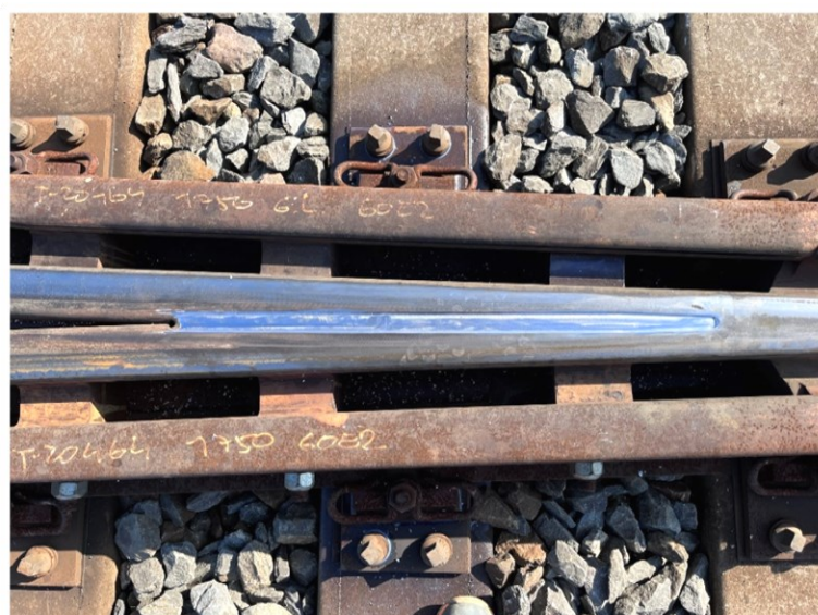
Obrázek 5 - Oblast hrotových kolejnic – s podélným svarem (výroba od roku 8/2023)
