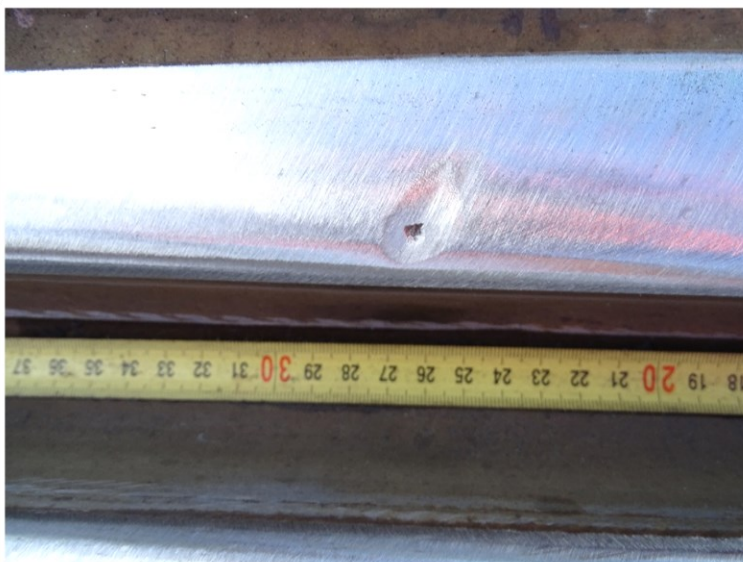
Obrázek 12 – Stav vady 511B po provedeném opravném broušení
